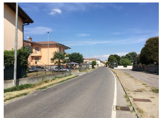
Assenza di marciapiede che colleghi l'abitato di via Pesadori e la zona in cui sono collocati i principali servizi (municipio, scuola, esercizi commerciali...)
