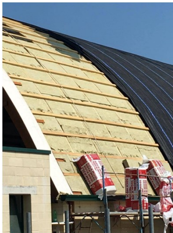
Posa strato in lana di roccia tra due teli impermeabili traspiranti (secondo strato del pacchetto di copertura)
