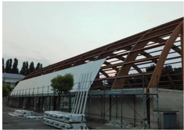
Posa della perlinatura in legno interna (primo strato del pacchetto di copertura)
