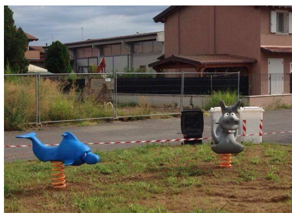
Parco di Passarera in fase di realizzazione
