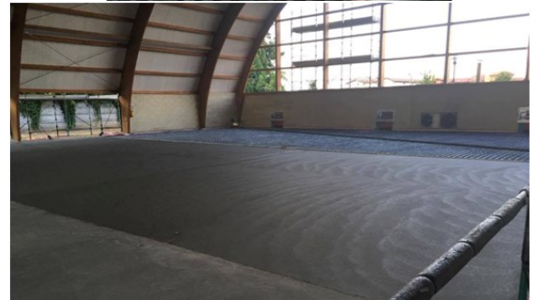
Fasi posa riscaldamento a pavimento
